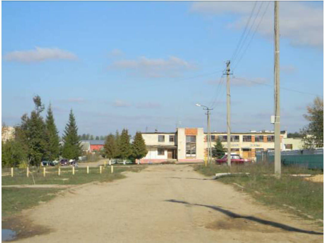
Здание бывшего торгового центра, пос. Нововолковский
